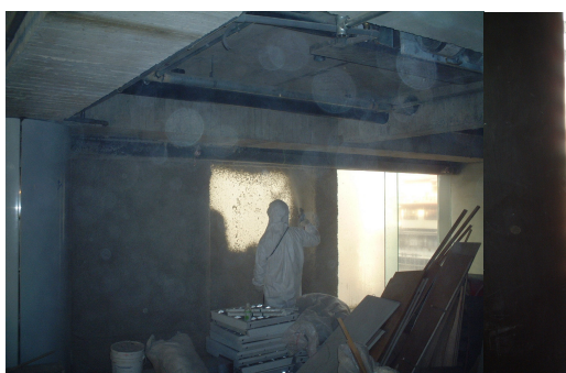
圖 13 以噴覆式制振材改善玻璃帷幕表面振動量
