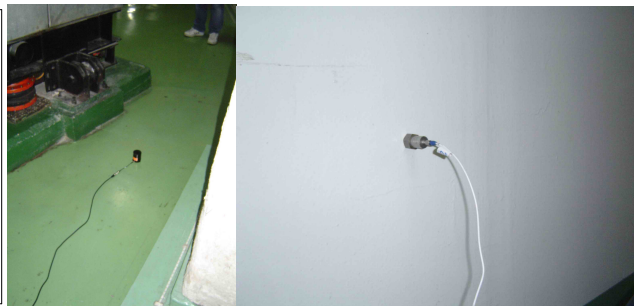
圖 10.機房機器旁牆面振動加速度頻譜圖
