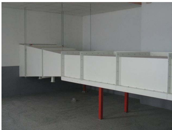
圖十五、落地風管支撐架橡膠墊隔振處理
