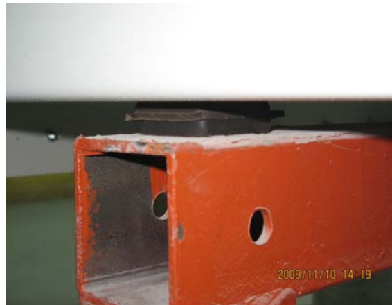
圖十五、落地風管支撐架橡膠墊隔振處理
