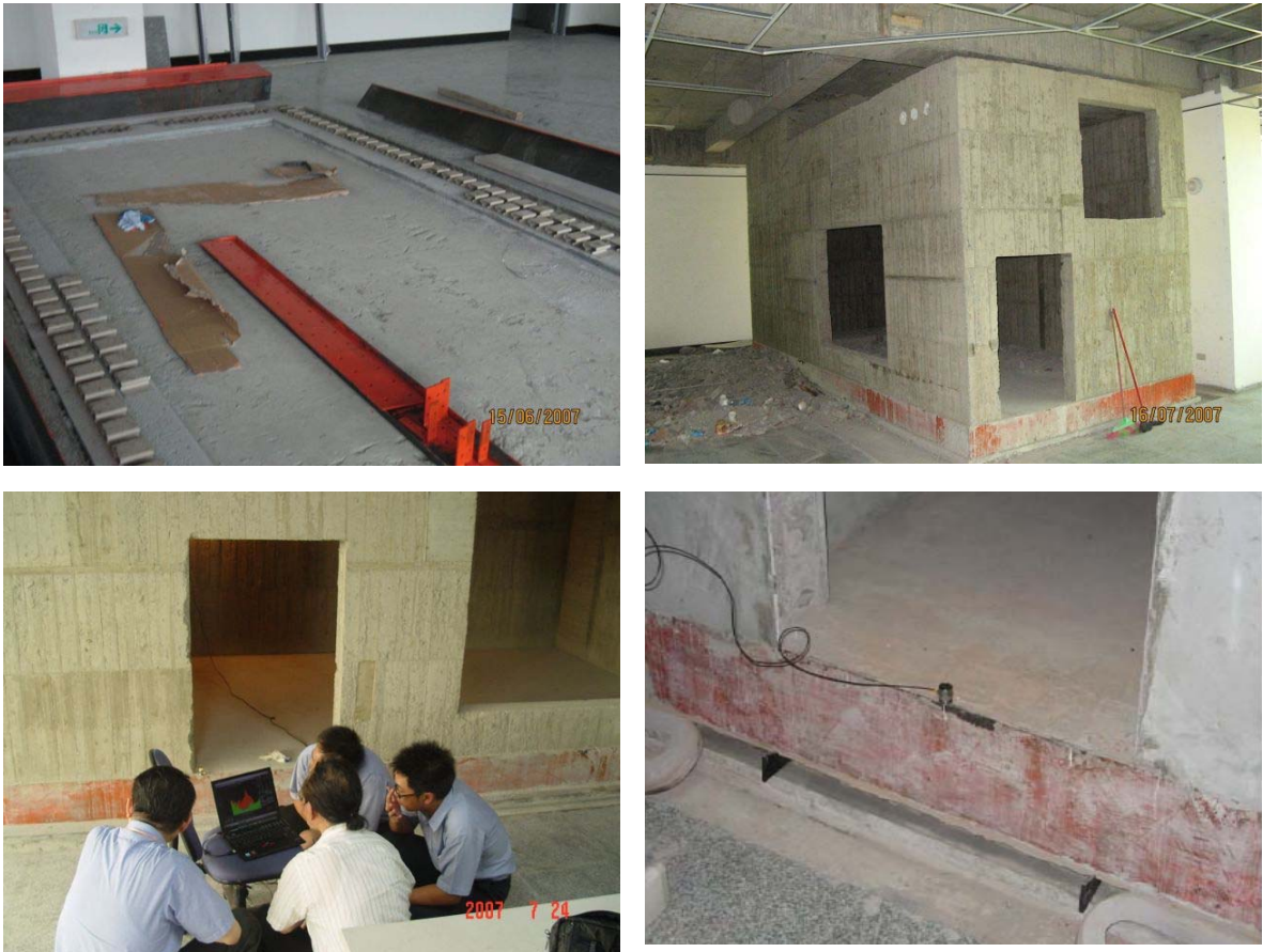
圖十二、音源室浮動地坪施作與施工中振動隔絕檢測
