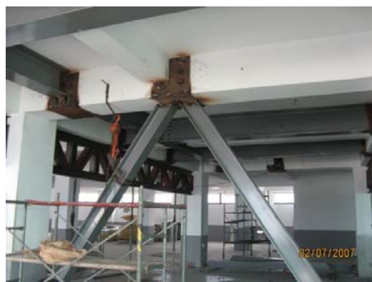
圖六、餘響室下之結構補強
