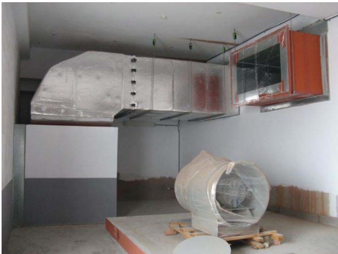
圖十八、風管由 6F 風車室轉入 5F 音源室
