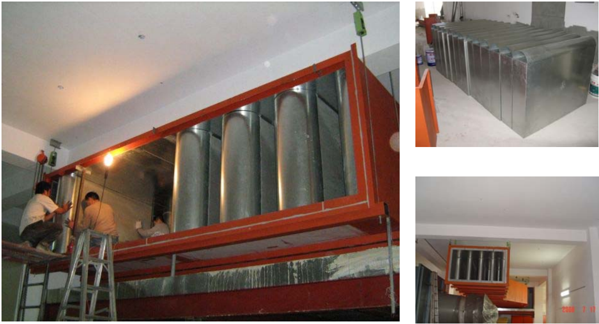
圖十一、風管消音箱施作
