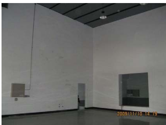
圖七、第一餘響室上方複層鋼板構造
