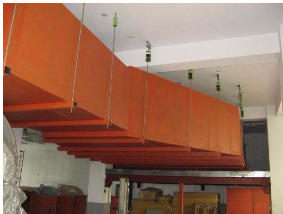
圖十四、風管系統彈性吊桿及撓性接頭
