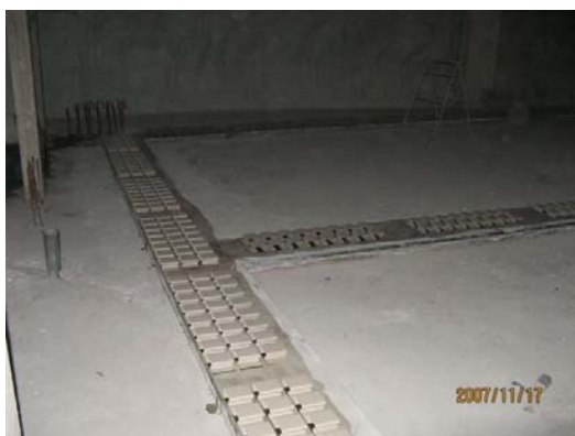
圖五、第一餘響室隔振彈簧配置
