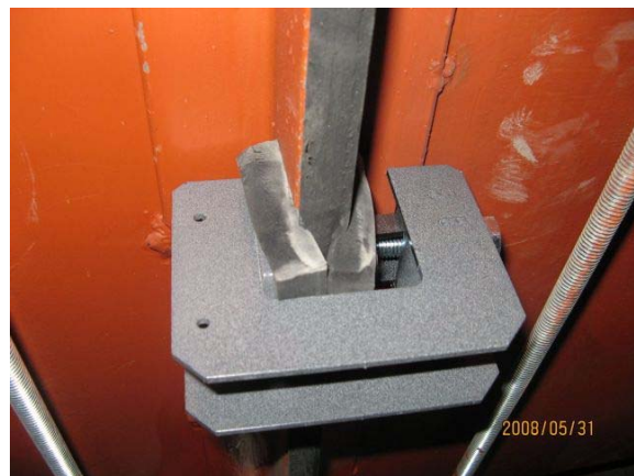
圖十四、風管系統彈性吊桿及撓性接頭
