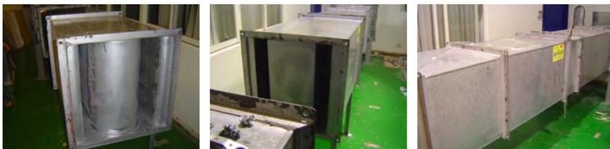
圖 4.2 Hds 消音箱入出風口端與安裝全圖
