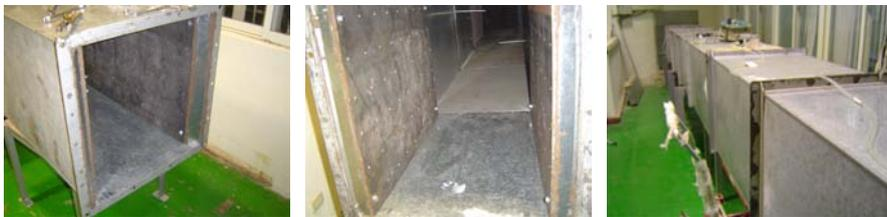
圖 4.1 Type-1 消音箱入出風口端與安裝全圖
