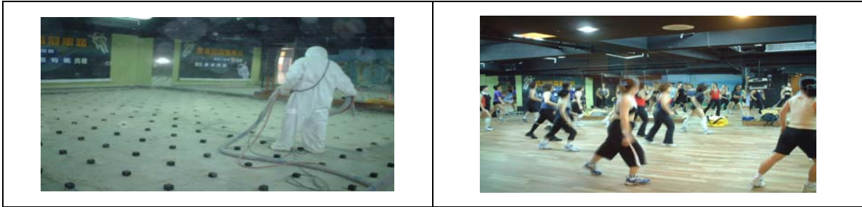
圖 4.1 RC 小面積樓板浮動地板施作及完工使用圖
