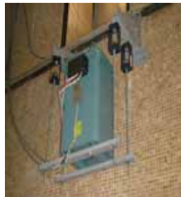
圖 31 家用變壓器隔振設計與現場完工圖
