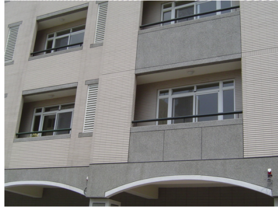
圖 8 新式陽台只求室內空間加大，使陽台變窄 (約 0.5 m)，降低降噪之功能。
