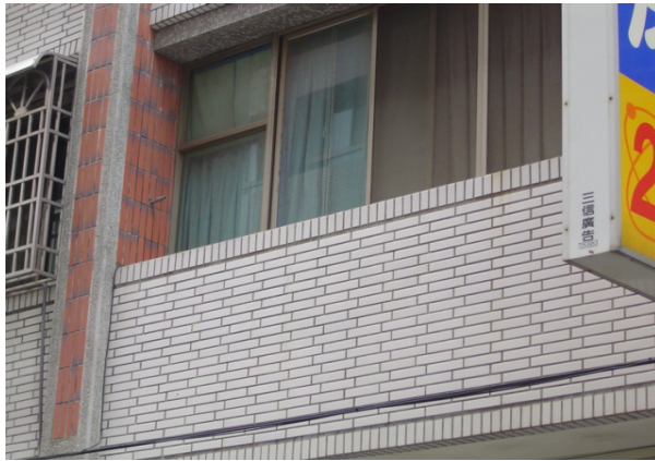
圖 7 新式陽台只求室內空間加大，使陽台變窄 (約 0.3 m)，降低降噪之功能。
