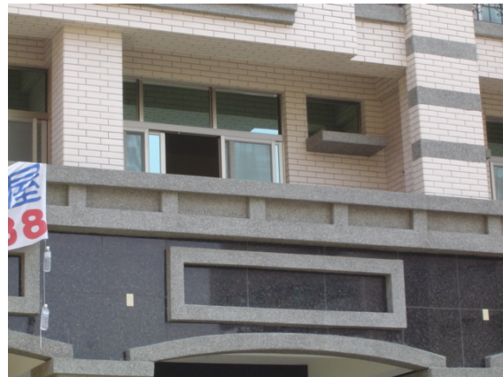
圖 10 擋板高度夠高，補足寬度的不足。
