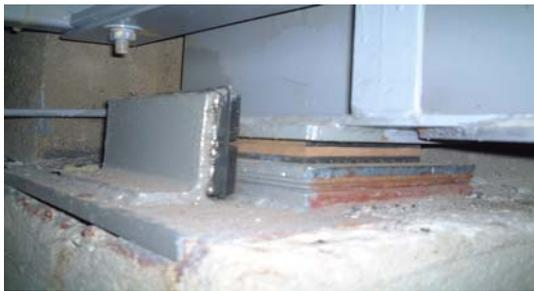
圖 21、原驅動馬達平台橡膠墊圖
